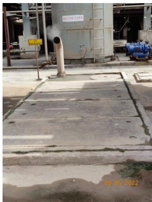
รูปที่ 2-13 บ่อพักน้ำ Blow Down ใต้ SP Boiler
