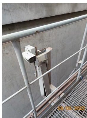
รูปที่ 2-48 การติดตั้งกล้องวงจรปิด สำหรับตรวจสอบระดับน้ำ ของหม้อไอน้ำ
