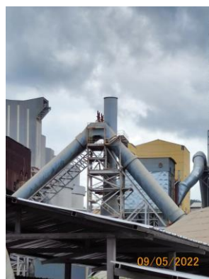
รูปที่ 2-52 ท่อลมร้อนที่ติดตั้ง Bypass Damper ของ AQC boiler
