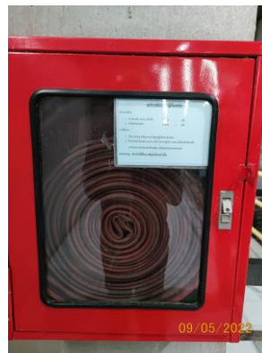
รูปที่ 2-38 ตู้เก็บสายดับเพลิง
