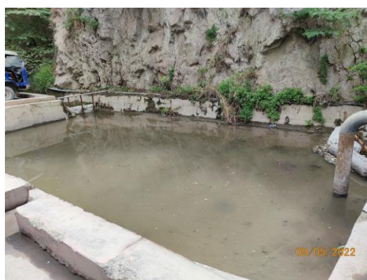
รูปที่ 2-12 บ่อพักน้ำ Blow Down ใต้ AQC Boiler
