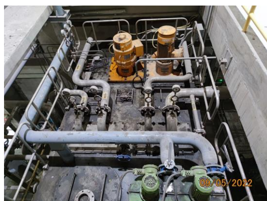
รูปที่ 2-57 การติดตั้ง DC Oil Pump ภายในโรงไฟฟ้า
