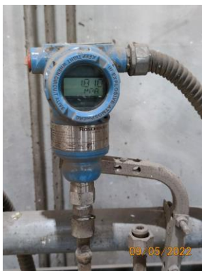
รูปที่ 2-49 Pressure Transmitter ของหม้อไอน้ำ
