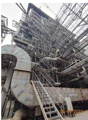
รูปที่ 2-41 อาคาร SP Boiler ที่มีทางเดินและบันได พร้อมราวกันตก
