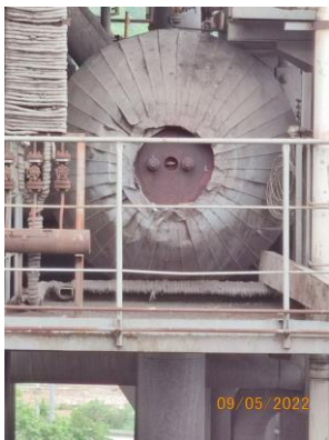
รูปที่ 2-43 Steam Drum ของหม้อไอน้ำ
