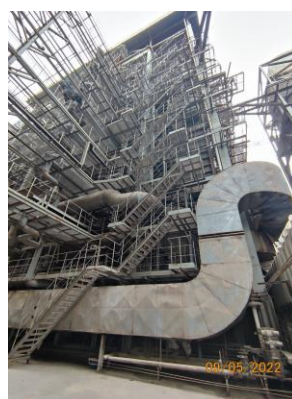
รูปที่ 2-42 อาคาร AQC Boiler ที่มีทางเดินและบันได พร้อมราวกันตก
