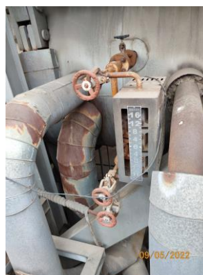
รูปที่ 2-46 เครื่องวัดระดับน้ำ ของหม้อไอน้ำ
