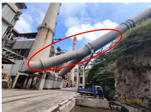
รูปที่ 2-33 ท่อลำเลียงลมร้อนออกจาก SP Boiler ในระบบปิด
