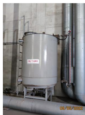
รูปที่ 2-58 การติดตั้ง Emergency Gravity Oil Tank ภายในโรงไฟฟ้า
