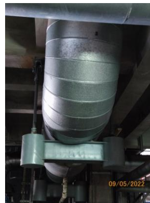
รูปที่ 2-32 ฉนวนกันความร้อนบริเวณท่อไอน้ำ
